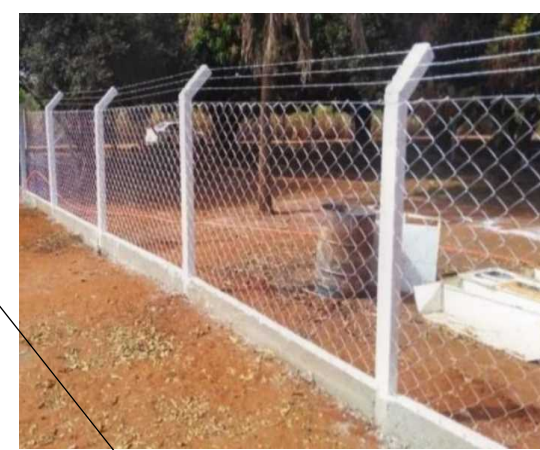
• COLOCAÇÃO DE GRADIL
