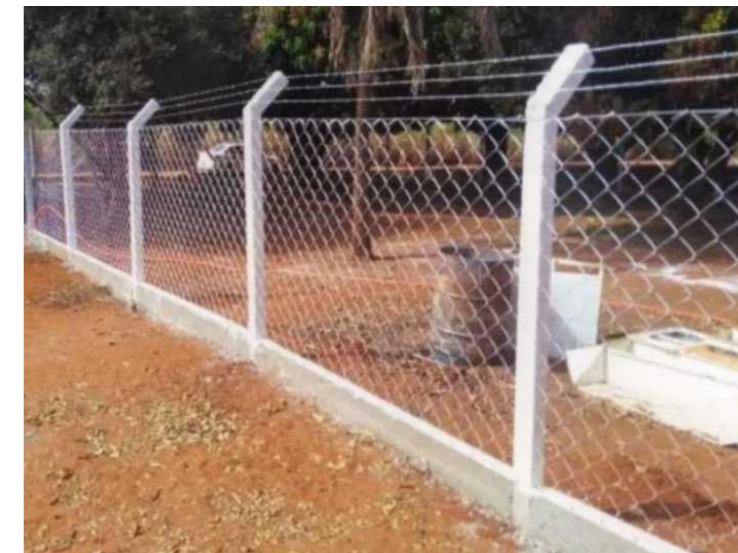
• COLOCAÇÃO DE GRADIL
