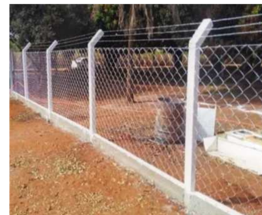
• COLOCAÇÃO DE GRADIL
